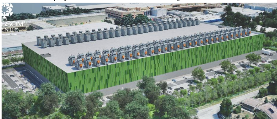
Viste di progetto – da via Edison – si notino i generatori diesel sul tetto e la presenza del parapetto (in alto a destra)
