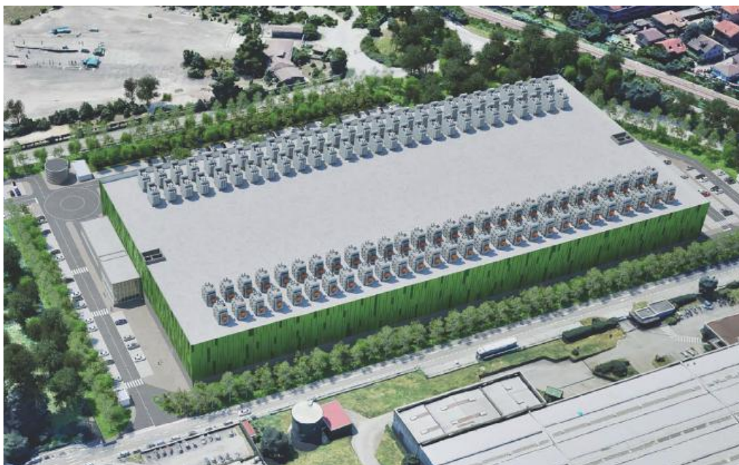
Viste di progetto – da via dell'Industrie – si notino i generatori diesel sul tetto
