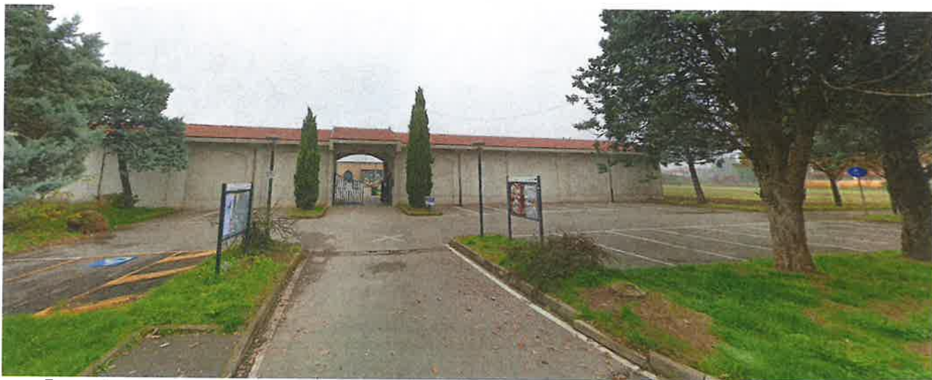
Fotografia con dettaglio dell'area antistante il cimitero di Mantegazza-Rogorotto da sistemare per garantire continuità ciclopedonale
