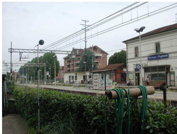
Foto 7 – Vista dello strumento di misura
