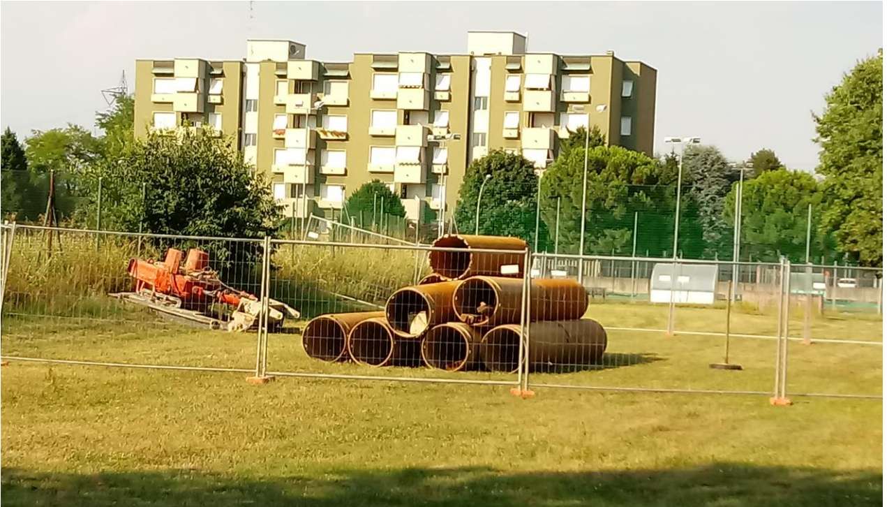
Il cantiere per la realizzazione del pozzo di prima falda
