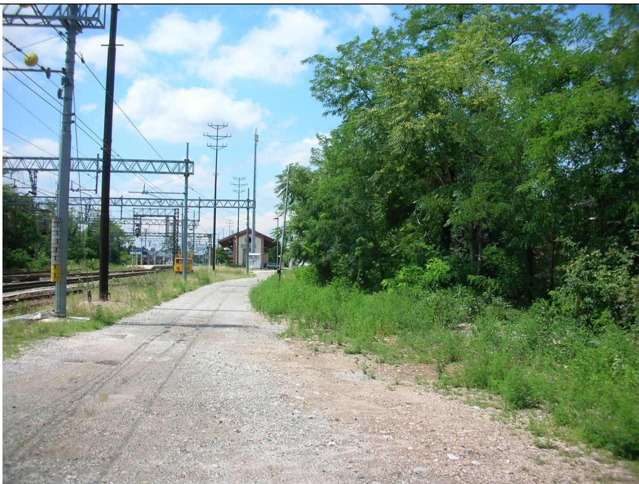
Vista dell'area di cantiere.
