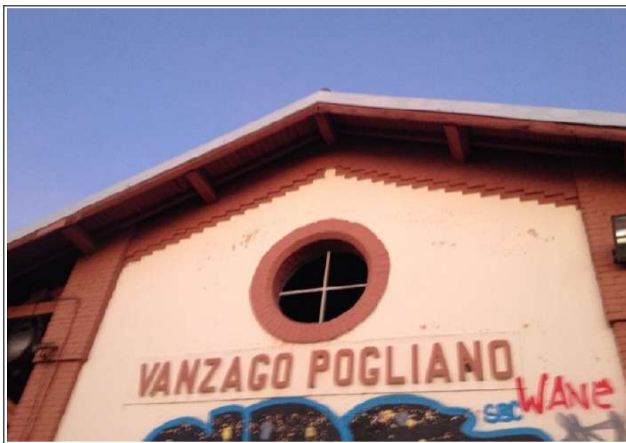
Fig. 2 di 2: particolare della testata sud-est
