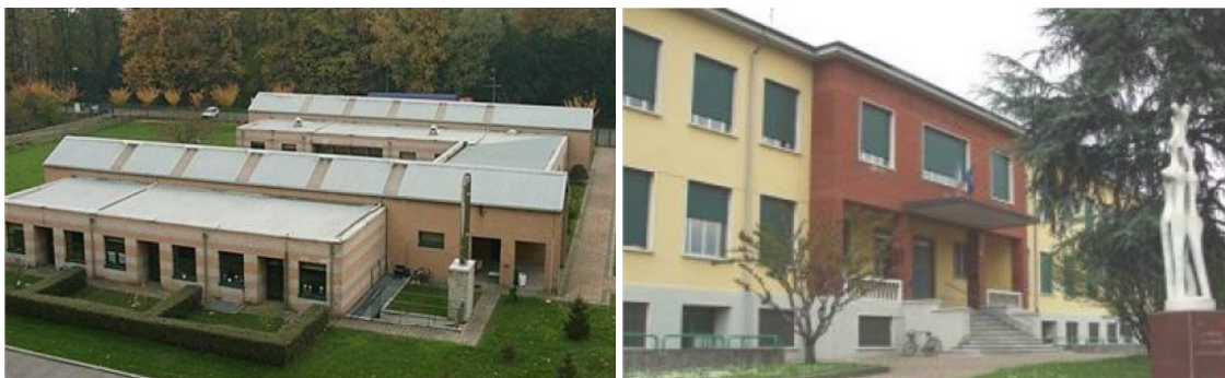
Scuola dell'Infanzia "Carlo Collodi" e Scuola Primaria "Paolo Neglia" – Vanzago [fonte: Ministero dell'Istruzione]
